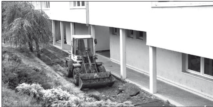
A hővezeték földmunkálatai a Petar Kočić iskolánál
