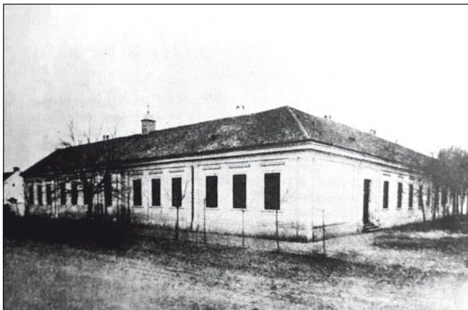
A zárda épülete a múlt század elején
