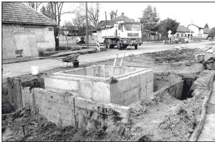
Szennyvízáttemelő akna a Rákóczi Ferenc és a Marko Orešković utcák kereszteződésénél (G. B. felv.)
