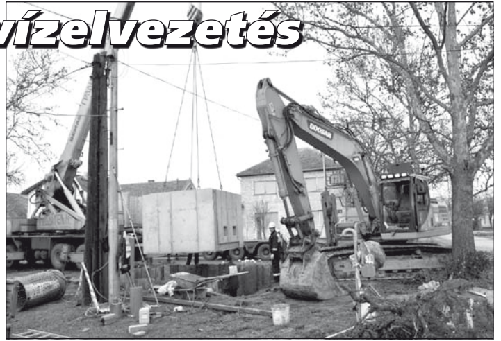
A Petőfi Sándor és a Rákóczi Ferenc utca kereszteződésében óriásdaru emeli be a szivattyúállomás betomelemét (V. Z. felv.)
