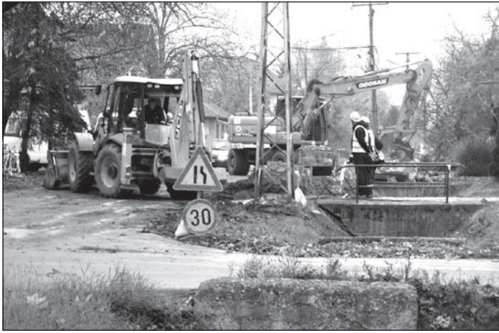
A szennyvízcsatorna csöveinek lefektetésével a Rákóczi Ferenc utcában eljutottak a Petőfi Sándor utcáig, ahol pillanatnyilag több elágazást helyeznek a földbe
