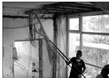
A tantermek nádszigetelésének eltávolítása, majd cseréje következik
