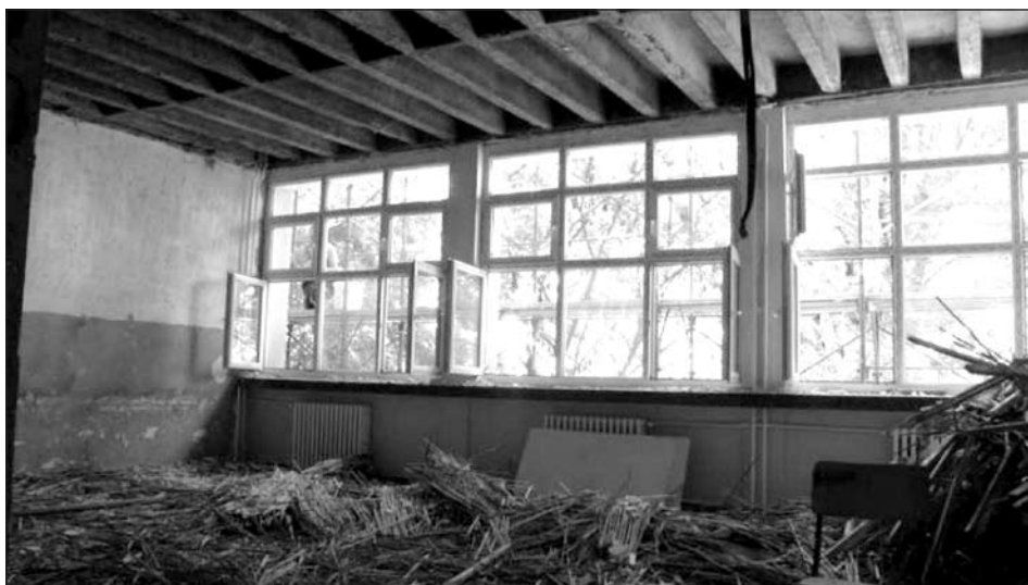
A tantermek nádszigetelésének eltávolítása, majd cseréje következik
