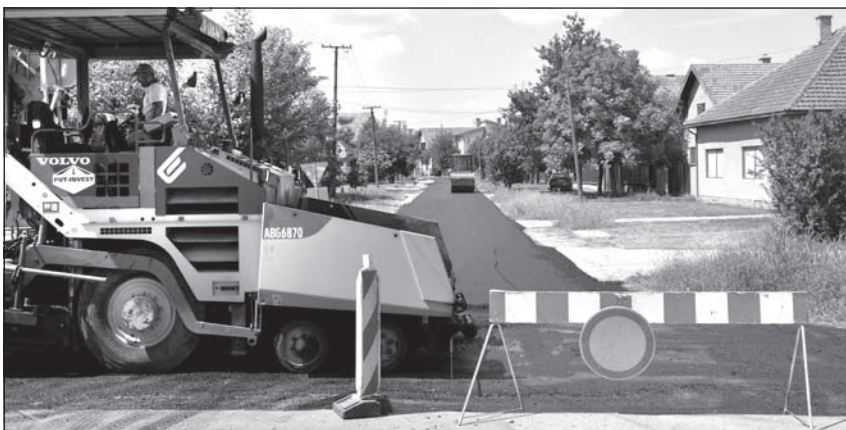
Új aszfaltréteggel vonták be az Ivo Lola Ribar utcát, ahol korábban szennyvízvezeték helyezették a földbe (Varga Z. felv.)
