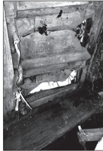
A villám egy cserépen keresztül hatolt be a faszerkezetbe, és szinte fogpiszkálószerű darabokra hasogatta a szelemenfát
