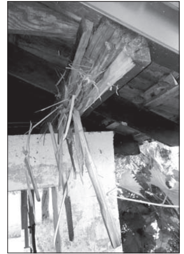
A villám egy cserépen keresztül hatolt be a faszerkezetbe, és szinte fogpiszkálószerű darabokra hasogatta a szelemenfát
