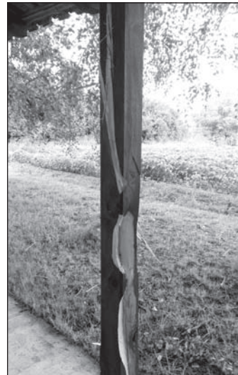
Iskolai tananyag fizikából, hogy a fa rossz elektromos vezető, továbbá az is, hogy az elektromosság mindig a legrövidebb utat keresi az ellentétes pólus felé. A képen a kiülő fából készült, villám által sújtott tartógerendái. D.
