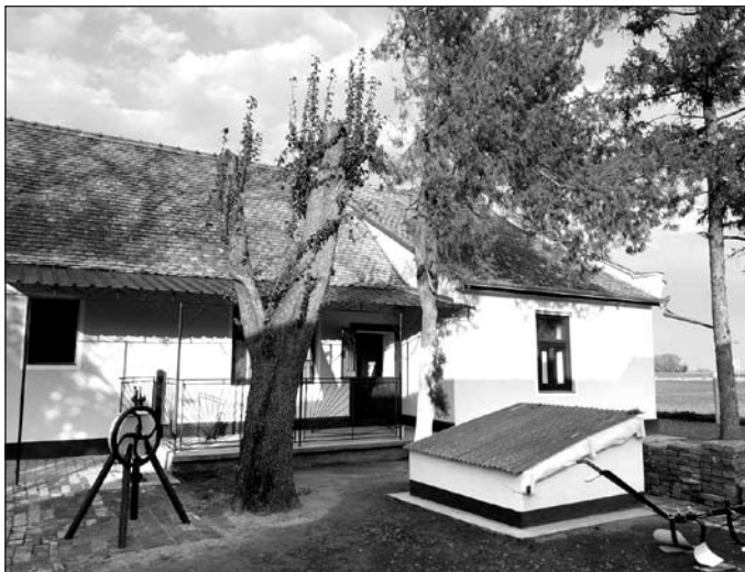
A felújított udvar
