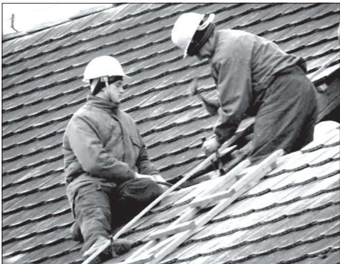
Helyükre kerülnek a templomtető cserepei – a mesterek befejezték a munkát
