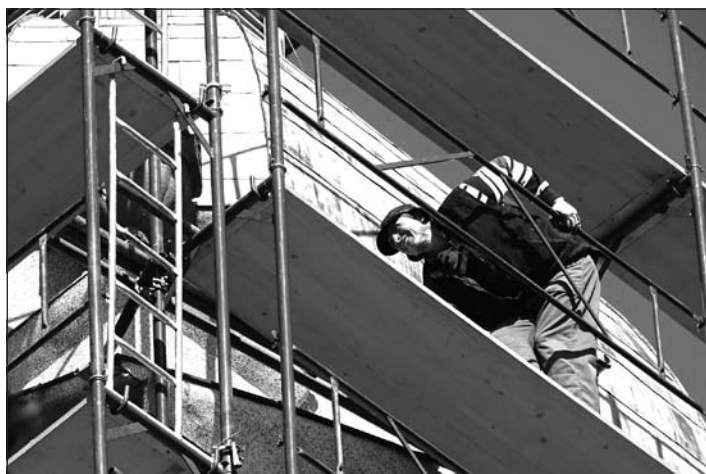
Kezdődhet a felújítás: Megépült az állványzat a torony sisakja körül
