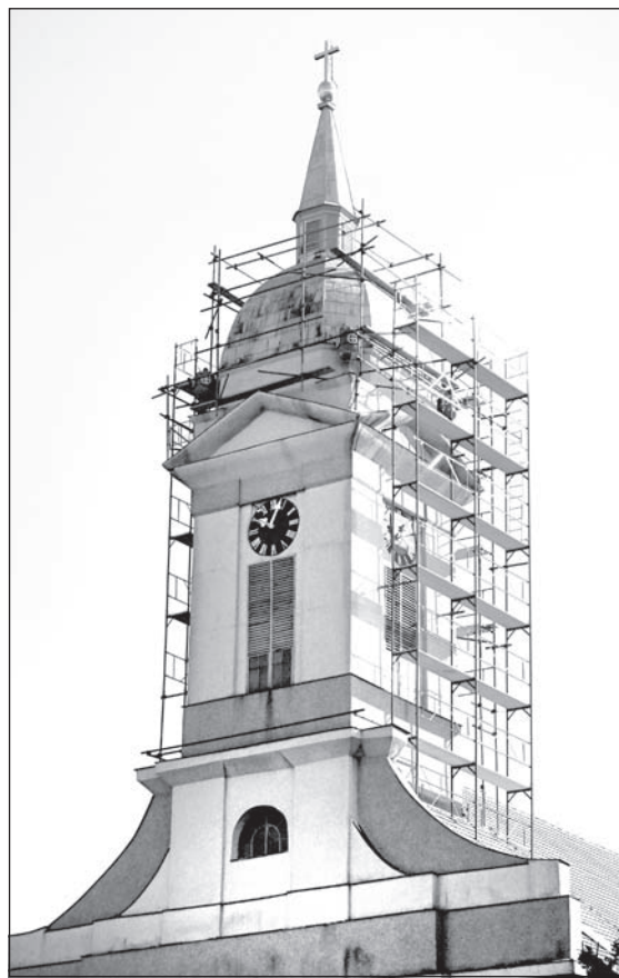
Elkészült az állványzat a templomtorony bádognisakjának új vörösrézlemezrel történő borításához
