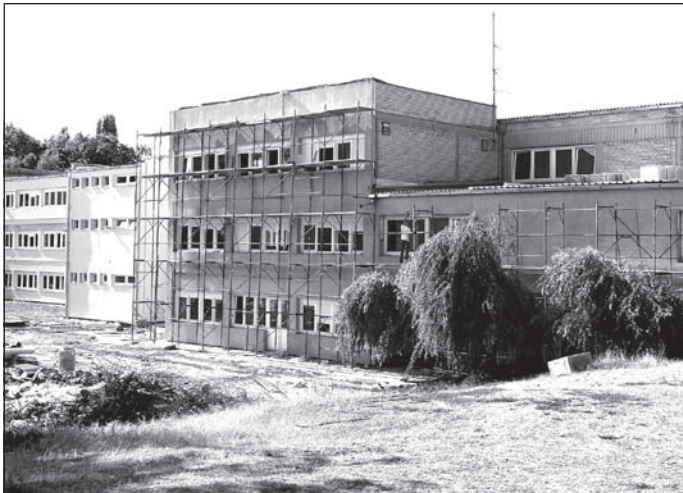
Szigetelő lapokkal borítják a Petar Kočić iskola jellegzetes, sárga téglás falait
