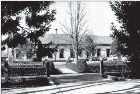
Az öreg iskola épülete a templom bejárata elől nézve
