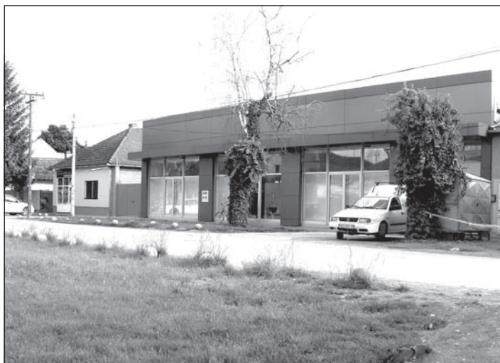
Elkészült a Petőfi Sándor utca keleti szakaszában a földszintes üzemház. Egyik részébe a hétvégén máris árut pakoltak be.
