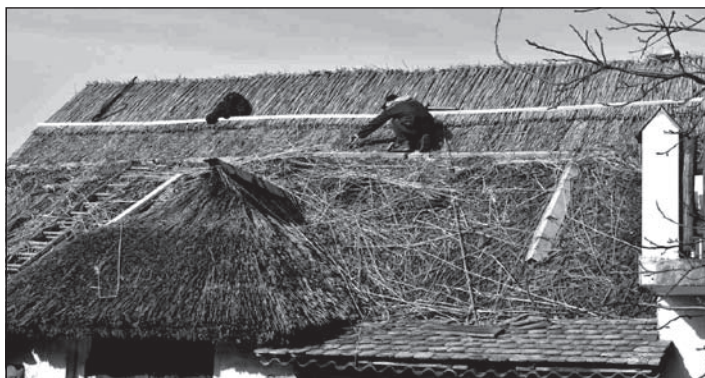
A részben felújított nádtető
