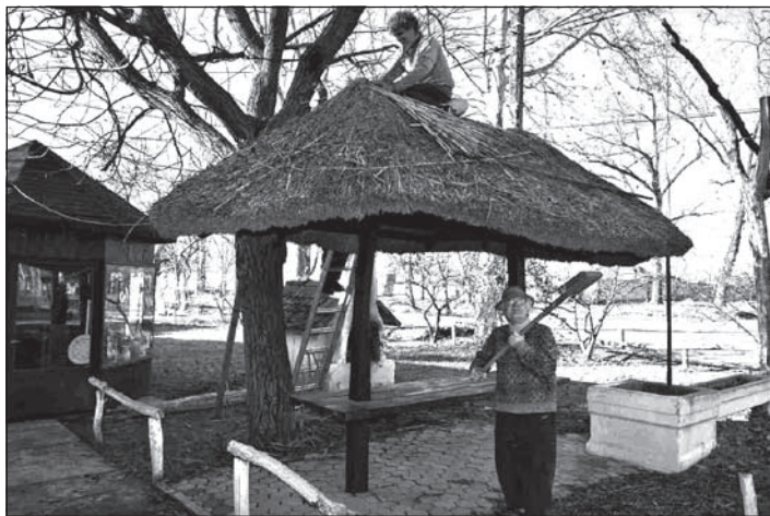
Majoros Pál pofozónak nevezett szerszámmal vasalja a tetőt
