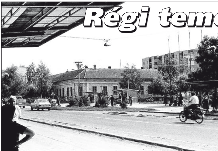
A régi község háza épülete
