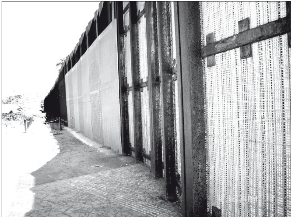
Vascölöpök között sűrű szövésű drótháló, fönt szögesdrót 1030 km hosszant
