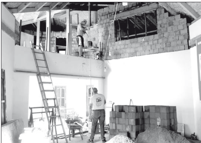
Beépül a tetőtér
