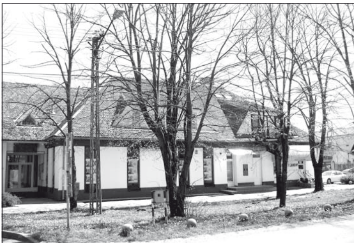
A volt parókia padlasterében lesz a közjegyzői hivatal
