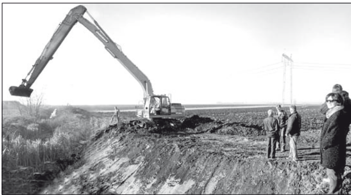
Kotrógép dolgozik a Sztatyna mélyítésén
