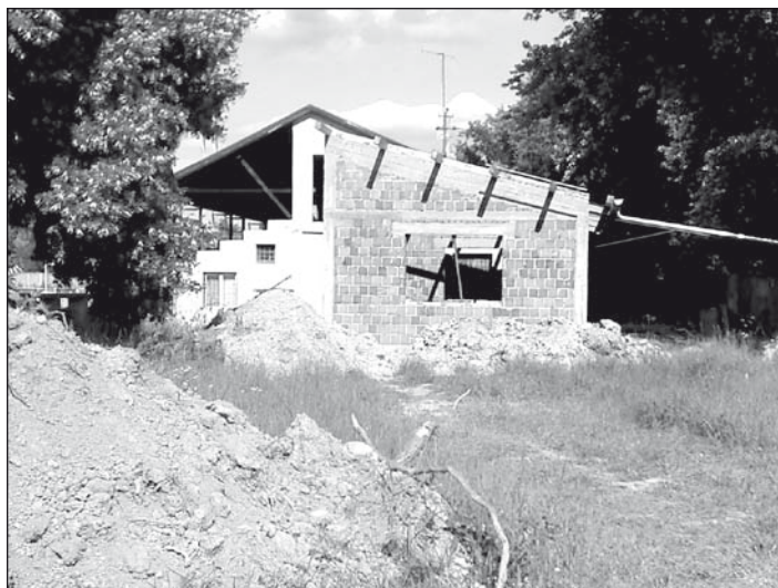
Felújították a TSK stadion tribünjének tetőzetét és a lelátó mellett is építkeznek
