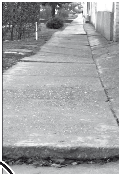
A vermek helyén megsüllyedt a betonjárda
