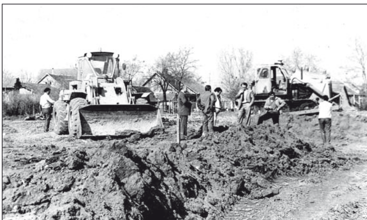
Előkészületek a termálvizes medence építési munkálataira
