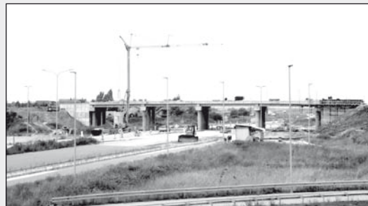
Az épülő nemzetközi úti felüljáró a temerini úti csomópont felől nézve
