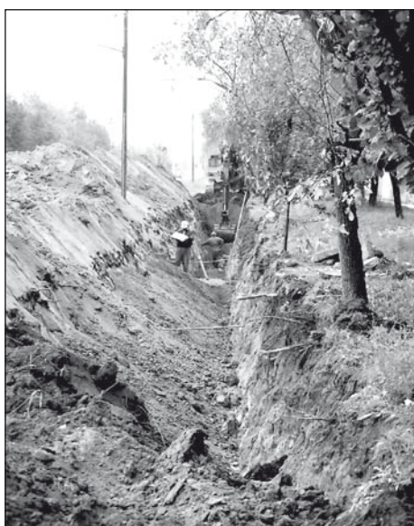
A fővezeték építésének földmunkálatai a Kastély utcában (T. Ú. archív fotó)
