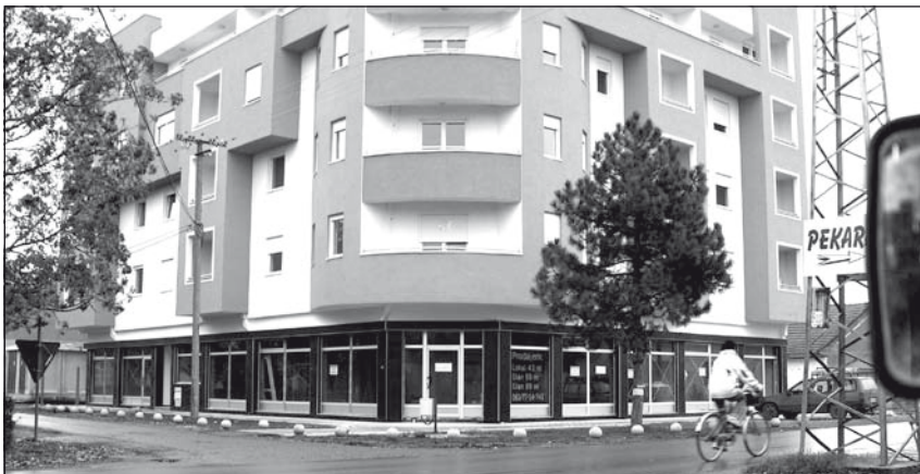
Mikorra télire fordul az időjárás, befejezik a nagyobb tömbházak építését is. Ebben az egykori Döme-ház helyén emelt épületben 27 lakás van.
