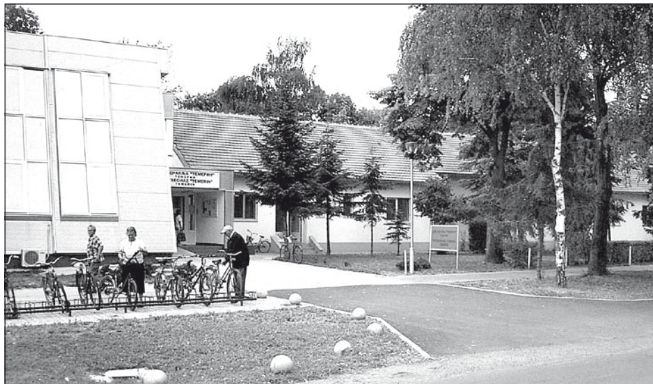
Most az egészségház régi épületének felújításán a sor
