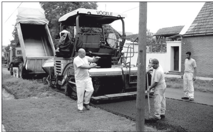
No, azért ne ilyen vastagon – aszfaltozók a Csillag közben
