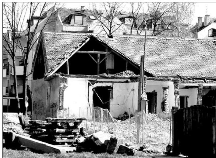
Újabb többemeletes lakóház építéséhez bontják a Zmaj Jovan és az Újvidéki utca sarkán lévő épületet
