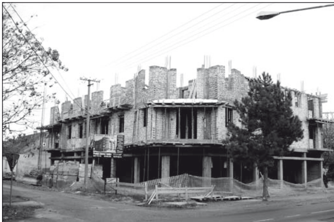
A Tanító utca 2-es szám alatt, az egykori Döme-ház helyén még tart a lakóház építése
